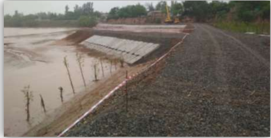
Состояние участка в ходе строительства
